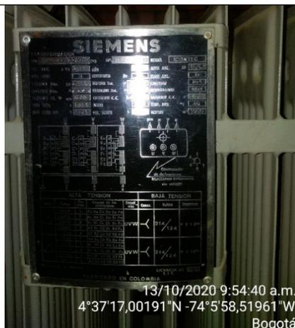
Fotografía 13. Placa transformador eléctrico
